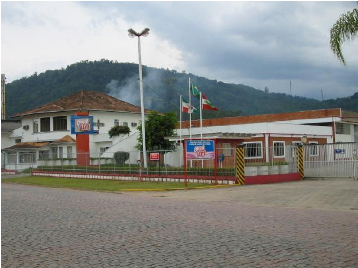
Figura 1 Vista Frontal da empresa
