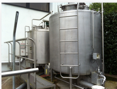
Figura 8: Tanques de estocagem de dejetos líquidos lácteos
