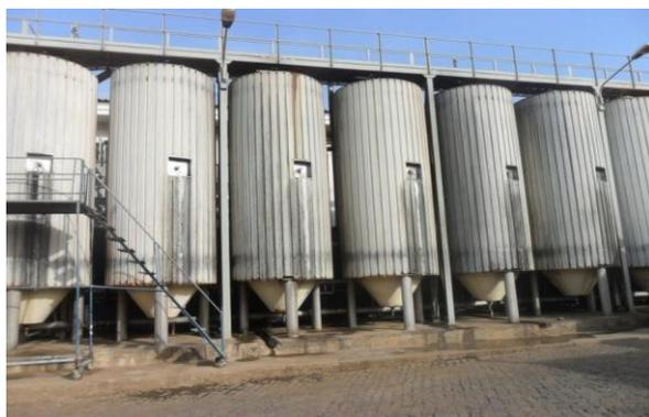
**Figura:** Tanques de fermentação (cubas).
